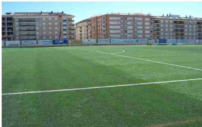
Apreciación de descompactación y tendido de la fibra
